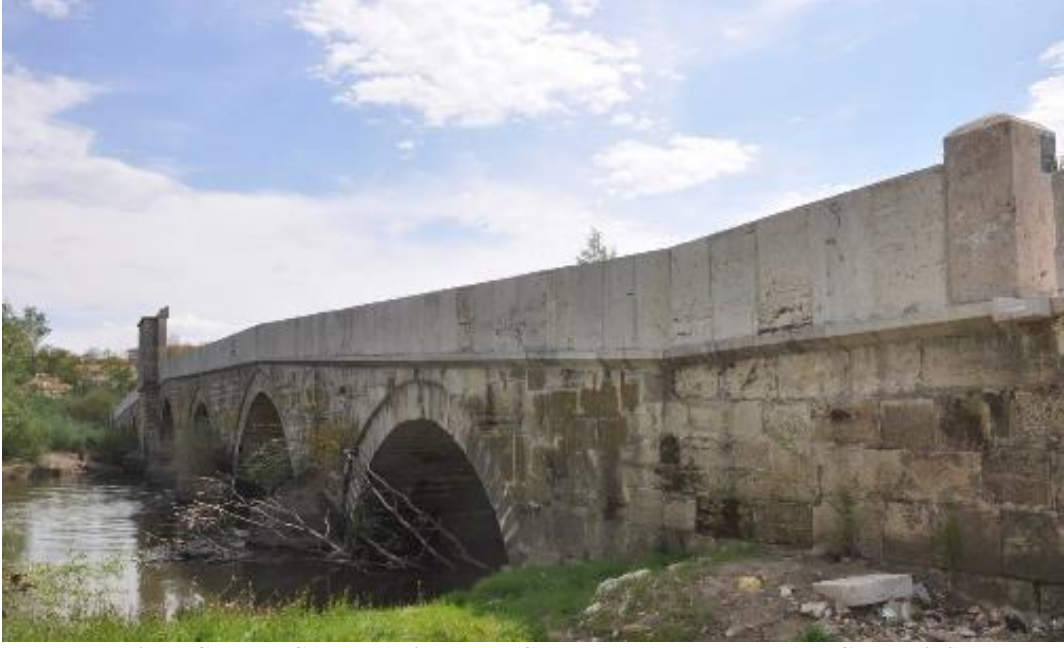
Edirne Sarayı, Şehabeddin Paşa (Saraçhane) Köprüsü (EYSK arşivi)
