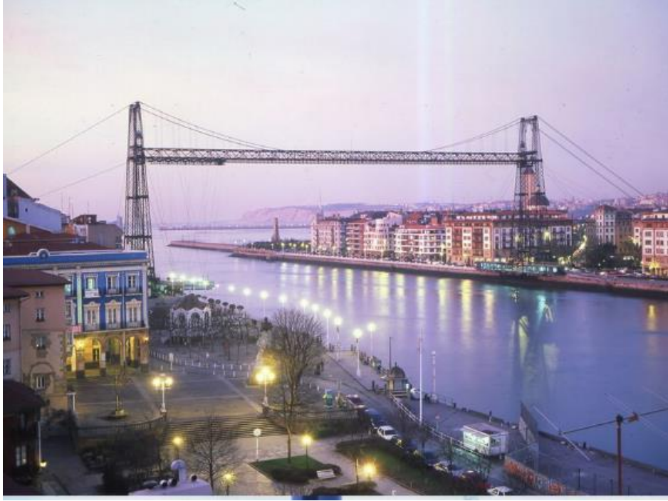
Resim 4- Ferdinand Arnodin'in Tasarladığı ve Uyguladığı Bilbao Puente Colgante Transporter Bridge'in (1893) Görünüşü
