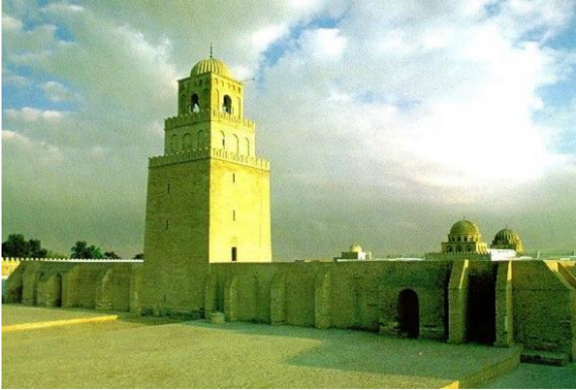
Resim 8- Kayrevan Seydi Ukba Camii'nin Minaresi
