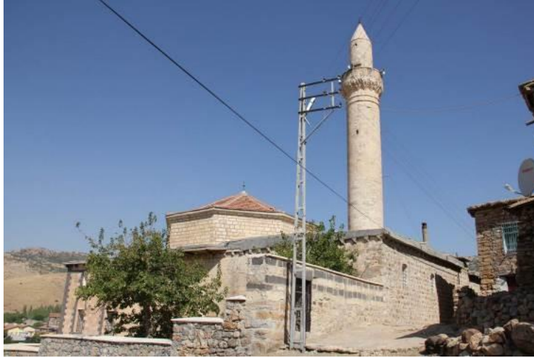
Foto:13 - Hazro Ulu Camii'nin Güneydoğu Cephesi.
