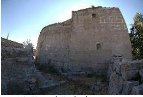
Res. 23) Kuzeydoğu Cephe.
