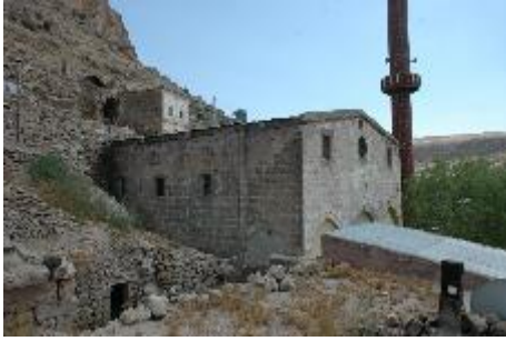
Res. 9) Kuzeybetıdan Genel Görünüm.
