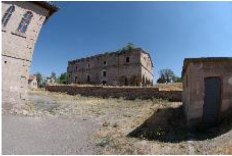
Res. 25) Kuzeydoğu Cephe.
