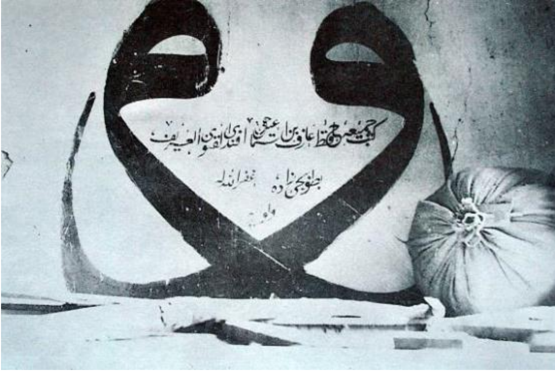
Foto. 21: Doğu Bölümün Kuzey Cephesindeki Günümüze Ulaşamayan Çifte Vav Hattı ve Ortasındaki Kalemîşi Kitabe 51 .
