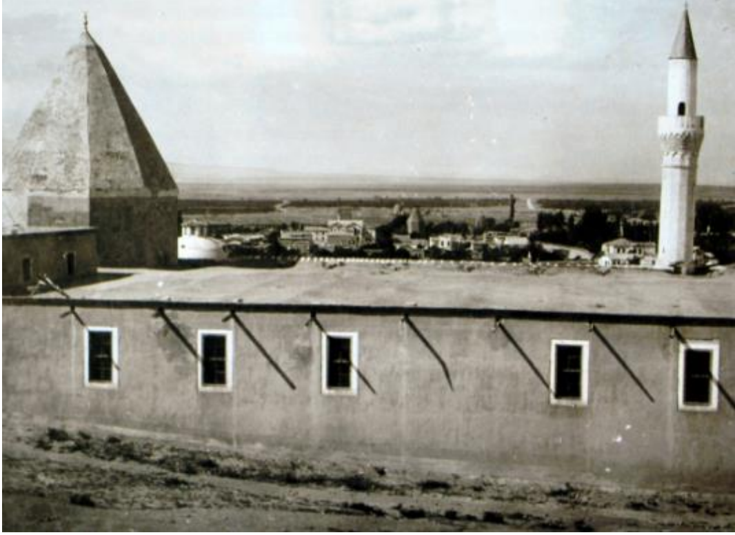
Foto. 19: Güney Cephenin Onarım sonrası vaziyeti (Ahmet Kuş Arşivi) 50 .
