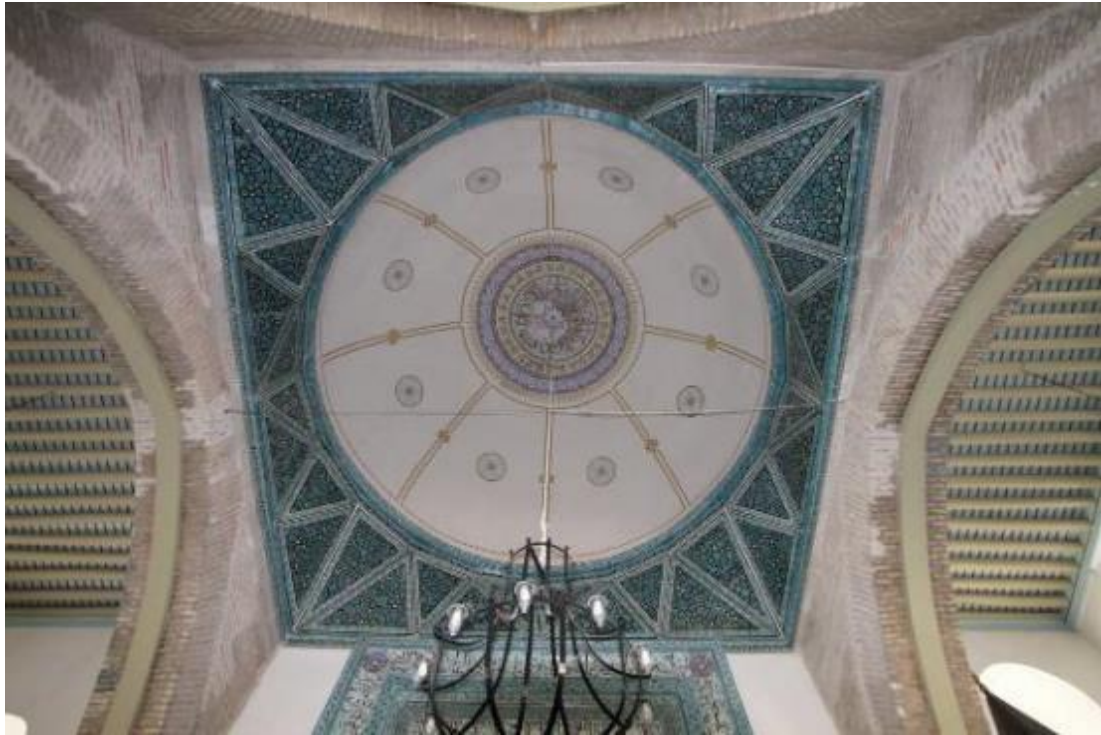
Foto. 24: Mihrap Önü Kubbesi ve İçerisinde Yer Alan Kalemîşi Süslemeler.
