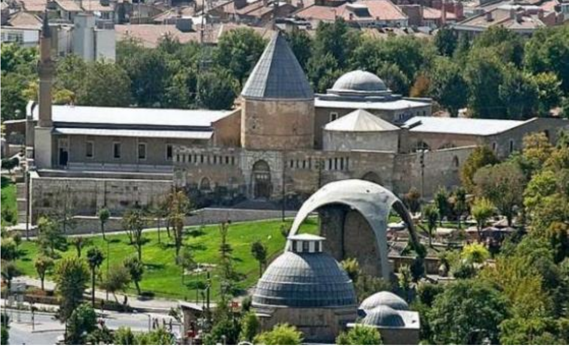
Foto. 3: Konya Alâeddin Camisi, Sultanlar Türbesi ve Yarım Türbe Genel Görünüşü 45 .
