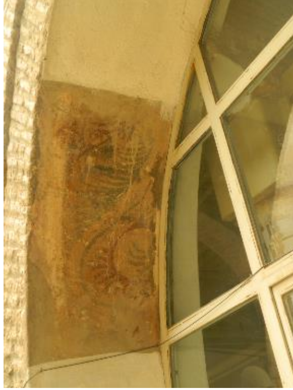
Foto. 25: Doğu Bölüm, Batı Cephe Kemerli Karnındaki Kalemîşi Süslemeler.
