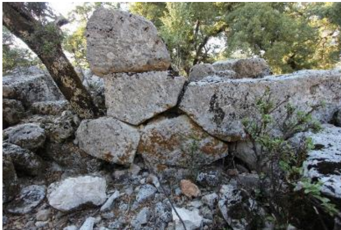
Şekil 6. Karabel çiftlik evi duvarından ayrıntı.
