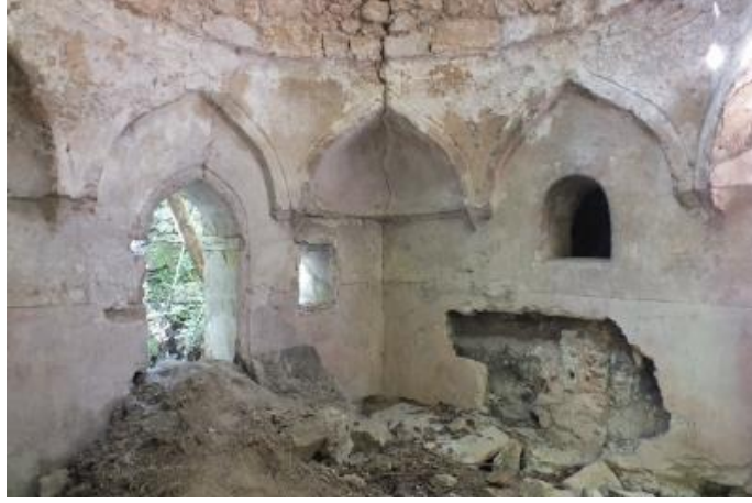
Resim 23. Kıranköy Musa Bey Hamamı. Sıcaklık Mekanı. Su Deposuna Açılan Pencere.
