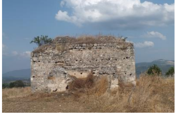
Resim 9. Kapucular Hamamı. Batı Cephe.
