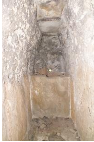
Resim 24. Kıranköy Musa Bey Hamamı. Su Deposu.
