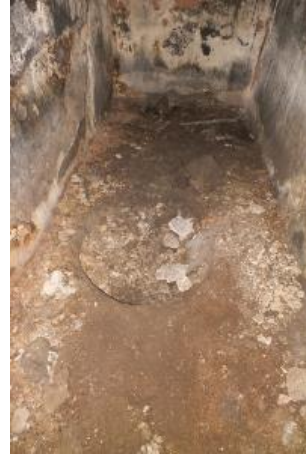
Resim 34. Bahçepınar Hamamı. Su Deposu. Kazan Çukuru.
