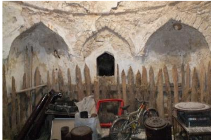
Resim 30. Bahçepınar Hamamı. 2. Sıcaklık Mekanı. Su Deposu Penceresi.
