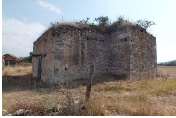
Resim 2. Kapucular Hamamı. Kuzeydoğu cephe.
