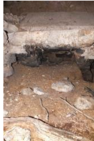
Resim 7. Kapucular Hamamı. Külhana Açılan Hava Kanalları.
