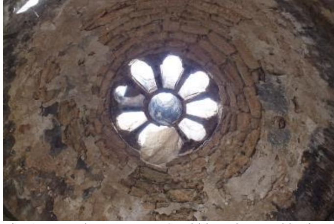
Resim 15. Kıranköy Hamamı. Sıcaklık Mekanı Kubbesi.
