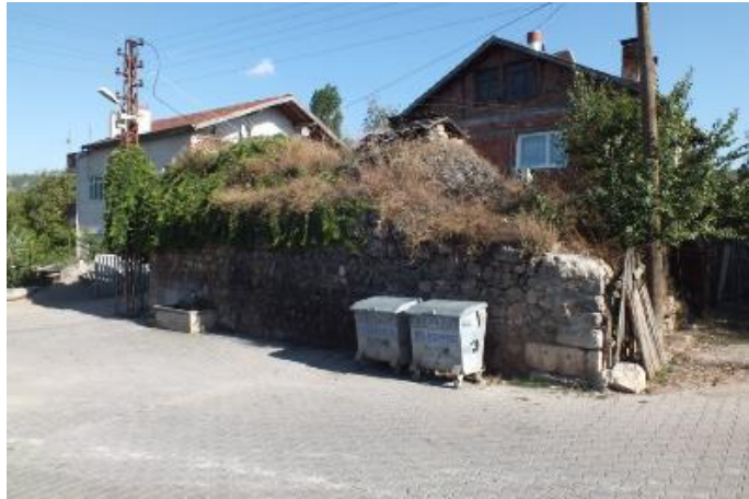
Resim 25. Bahçepınar Hamamı. Kuzey Cephe.
