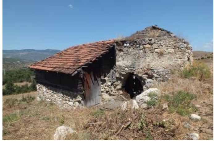
Resim 11. Kıranköy Hamamı. Güneybatı Görünüm.
