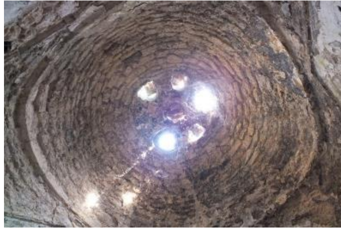
Resim 29. Bahçepınar Hamamı. 1. Sıcaklık Mekanı Kubbesi.
