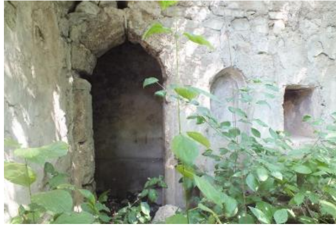
Resim 18. Kıranköy Musa Bey Hamamı. Tıraşlık Mekanına Geçiş.
