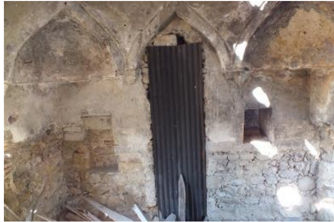
Resim 14. Kıranköy Hamamı. Soğukluk Mekanı ile Sıcaklık Mekanı Arasındaki Duvar.
