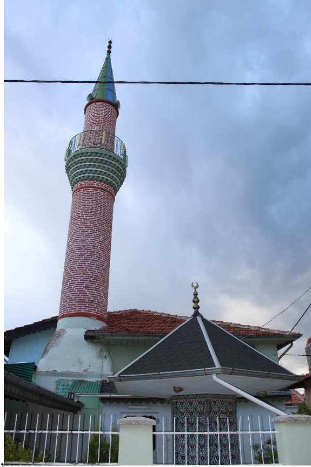
Fot.8- Ulubey-Tahtalı Camii Kuzey Cephesi ve Minaresi.
