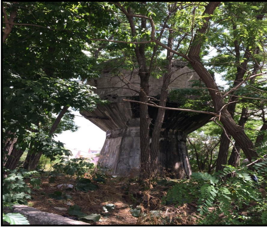
Fotoğraf 1. Kent mezarlığının bitişğinde ve 1642 m zemin kotunda bulunan su deposundan bir görünüm.
