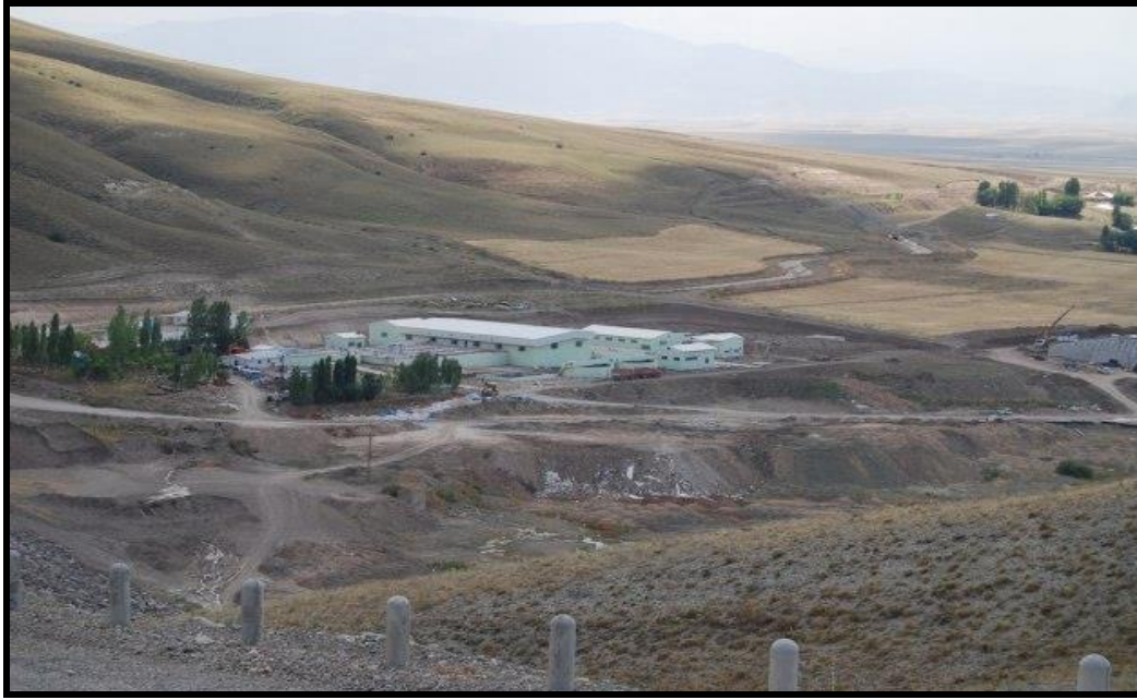
Fotoğraf 6. Yazıcı Barajı Arıtma Tesislerinden genel bir görünüm
