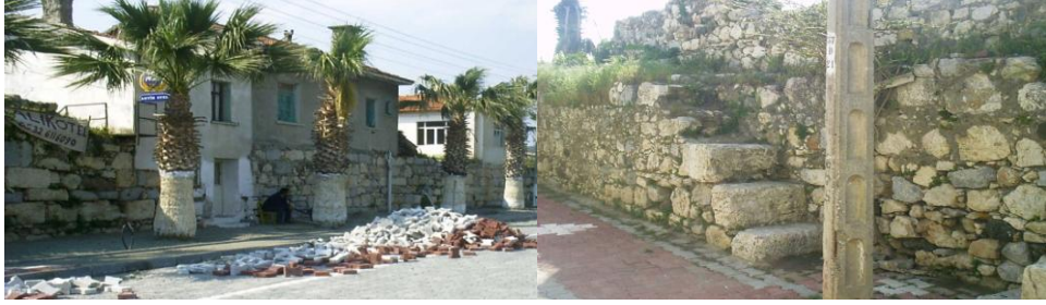
Resim 13. Güneydoğu Sur Duvarı ve Kuzeybatı Sur Duvarı 2012
