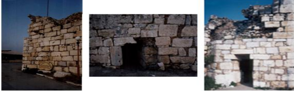
Resim 30. Güneybatı ve Kuzeybatı Burcunun Yıkılmakta Olan Üst Kat Görünümü, 2012
