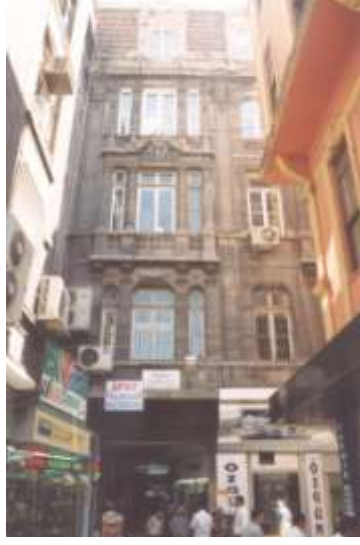
Foto.: 30- Ömer Abed Han Batı Cephe Giriş Aksından Görünüm.
