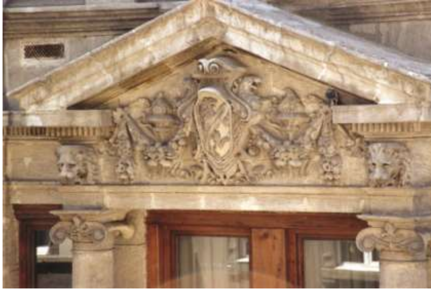
Foto.: 17- Osmanlı Bankası Genel Müdürlük Binası Kuzey Cephenin Üçgen Alınlıklarından.
