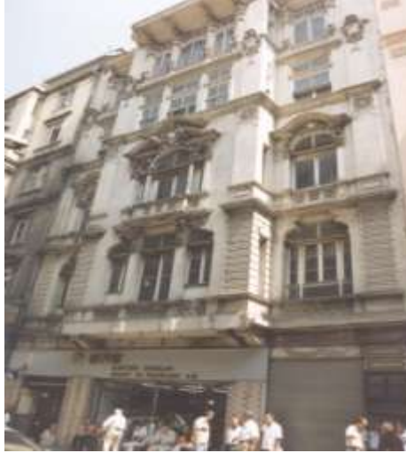
Foto.: 21- Hezaren Han Güneybatı Cepheden Görünüm.
