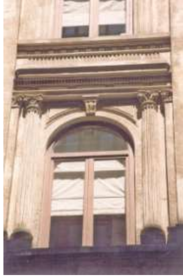
Foto.: 3- Demirbank Binası Güney Cephesinden Ayrıntı.
