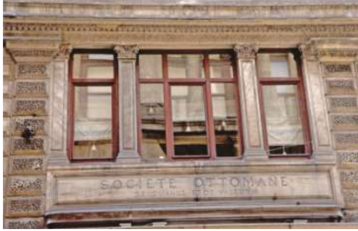
Foto.: 2- Demirbank Binası'nın Kitabesi.
