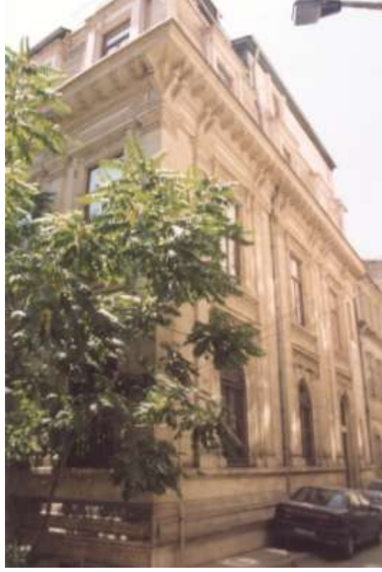
Foto.: 5- Demirbank Binası Kuzey Cephesinden.
