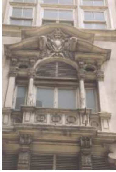
Foto.: 23- Hezaren Han Güneybatı Cephede Yer Alan Orta Pencere.
