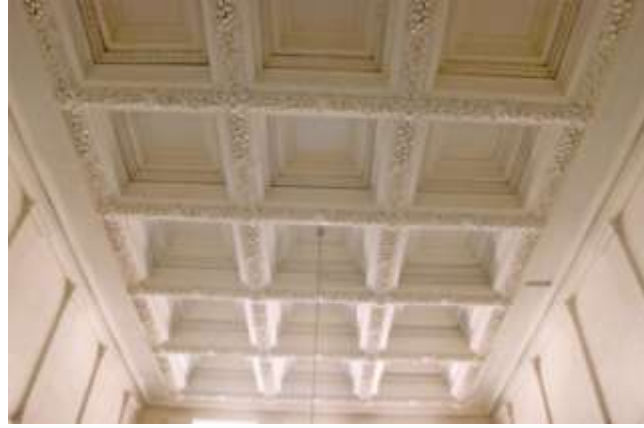
Foto.: 15- Osmanlı Bankası Genel Müdürlük Binası Giriş Holünü Örtün Kasetli Tavan.
