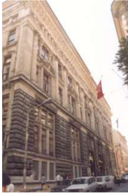
Foto.:7- Osmanlı Bankası Genel Müdürlük Binası Kuzey Cepheden Genel Görünüm
