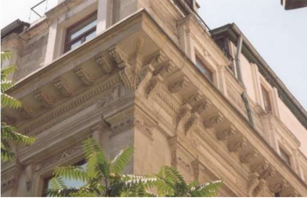
Foto.: 4- Demirbank Binası Çatı Saçağından.
