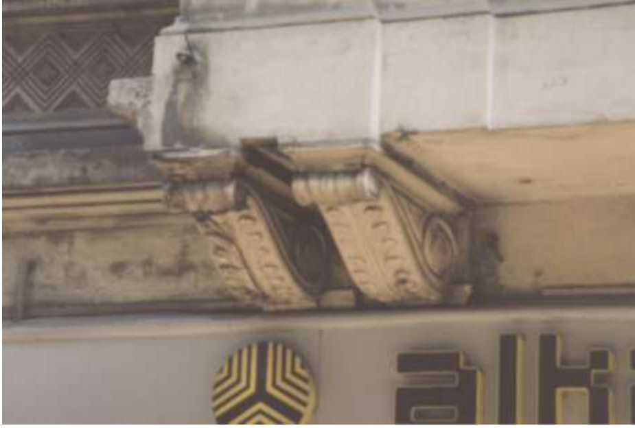
Foto.: 22- Hezaren Han Güney Cephenin Orta Aksındaki Cumbayı Taşıyan Konsollar.
