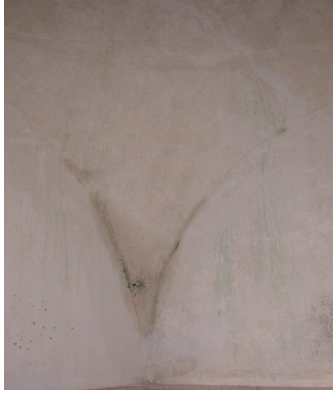
Foto. 4. Birinci sıcaklık bölümü kubbeye geçiş sistemi
