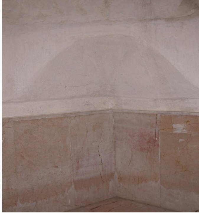
Foto. 5. İkinci sıcaklık bölümü kubbeye geçiş sistemi
