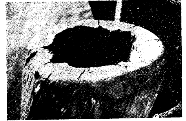
RESİM 6. Bir Çam iskele direğinde Kovuk çürüklüğü
