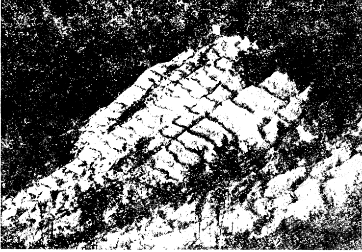
Resim 11: Yamaçlardaki toprak hareketlerine karşı, yamaç alanında söğüt dallarının kordon tarzında dikim. Kordonların aralarında kalan alanlara kızılbaş fidanları dikilmiştir.
