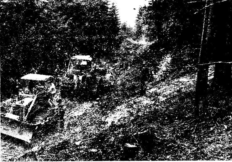
Resim 3: Bir orman şosesinin açılmasında, önde büyük (160 PS), arkada küçük (65 PS) iki buldozerin beraber çalışması. Büyük makine kaba olarak yolu açıyor. Küçük makine ince tevsiyeyi yapıyor ve şevleri tıraş ediyor (Foto: Tavşanoğlu)
