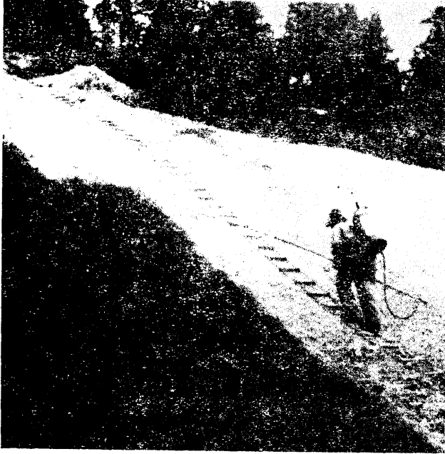
Resim 10 : Şev alanlarının yeşillendirilmesi maksadiyle bu alanlara buğday, ya da arpa saplarının döşenip tohum ekildikten sonra soğuk asfalt emülziyonun püs-kürtülmesi.
