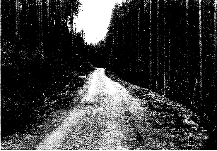
Resim 1 : İnşaatı tamamlanmış, çakıl serilmek ve silindirlemek suretiyle kaplanmış bir orman şosesi (Foto : Taşanoğlu)
