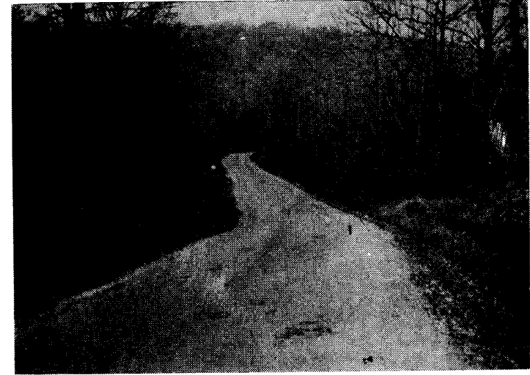
Resim 1. Bahçeköy -Kurtkemerli orman şosesinden bir görünüş
