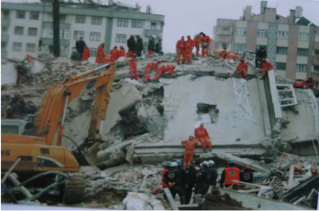
Şekil 4: Yetersiz Denetim ve Kalitesiz Betonarme Yapı
