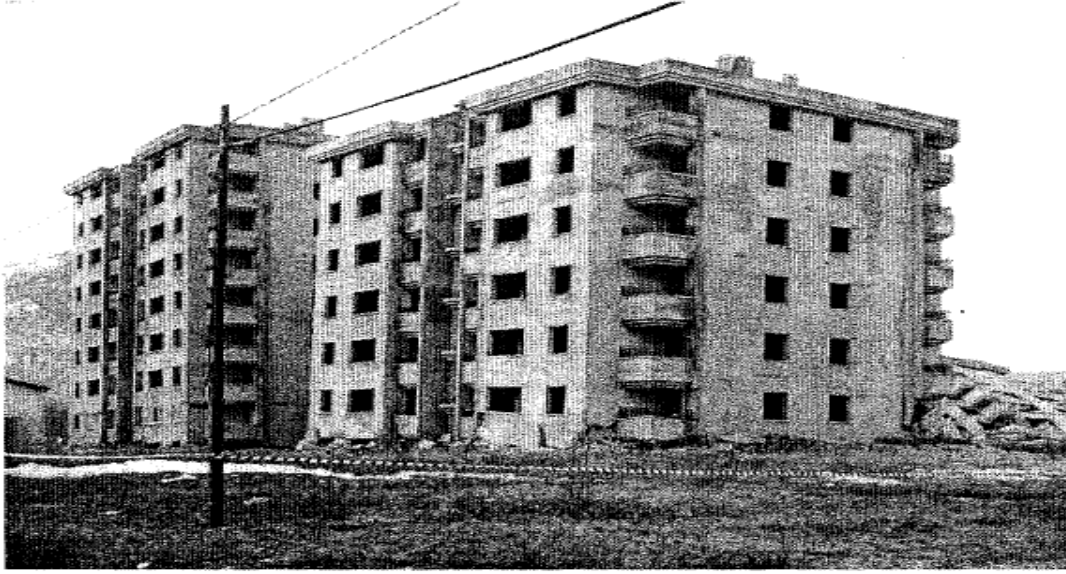
Şekil 5: Konut Yapı Kooperatifi İnşaatından Hasar Görüntüsü (3 Katı Yer İçine Çökmüş Bir Bina)
