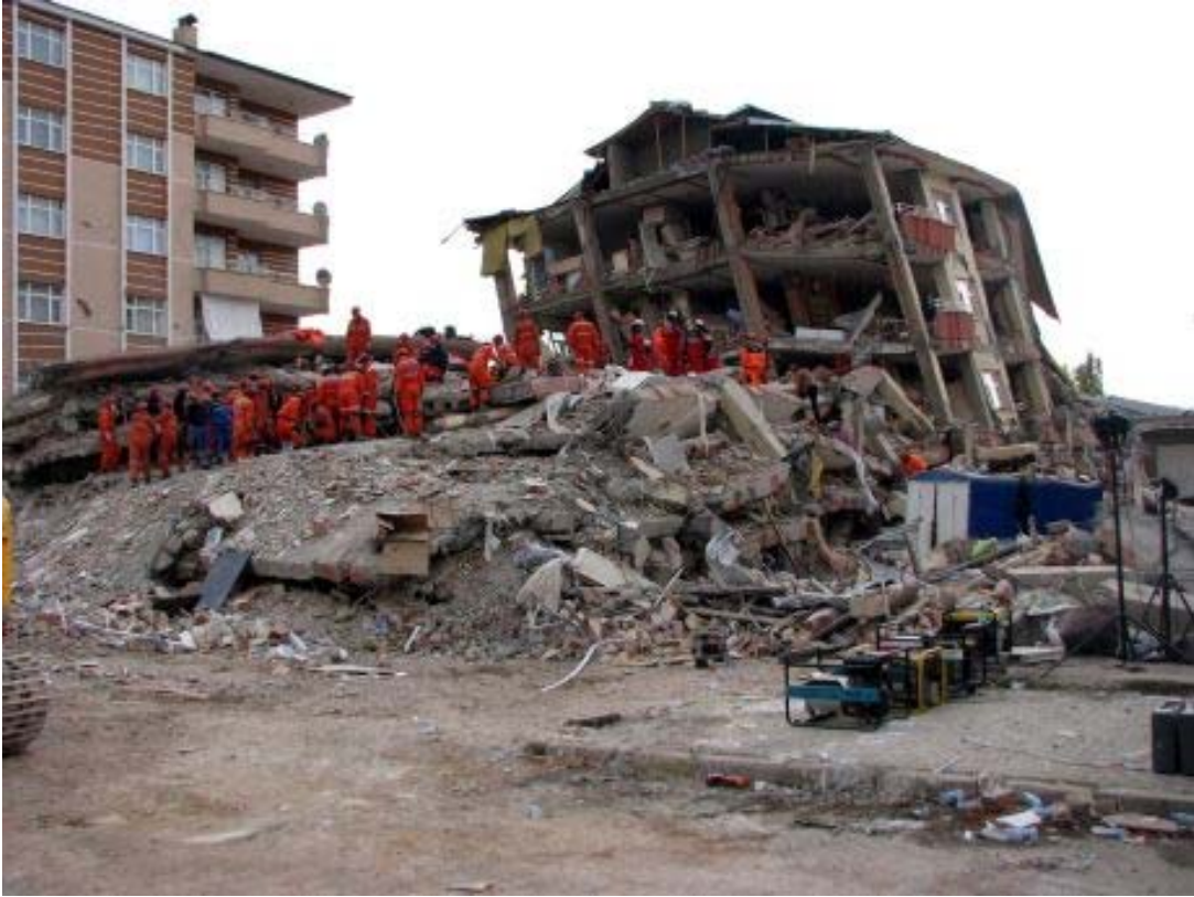
Şekil 7: Sevgi Apartmanı – Van 2011
