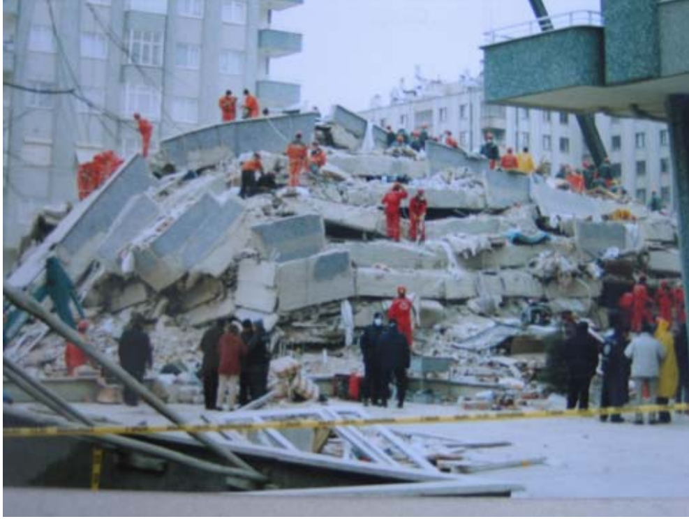
Şekil 3: Betonarme Karkas Yapıda Malzeme, Tasarım, Uygulama Hataları Sonucu Yıkılan Sekiz Katlı Yapı Görünüşü
