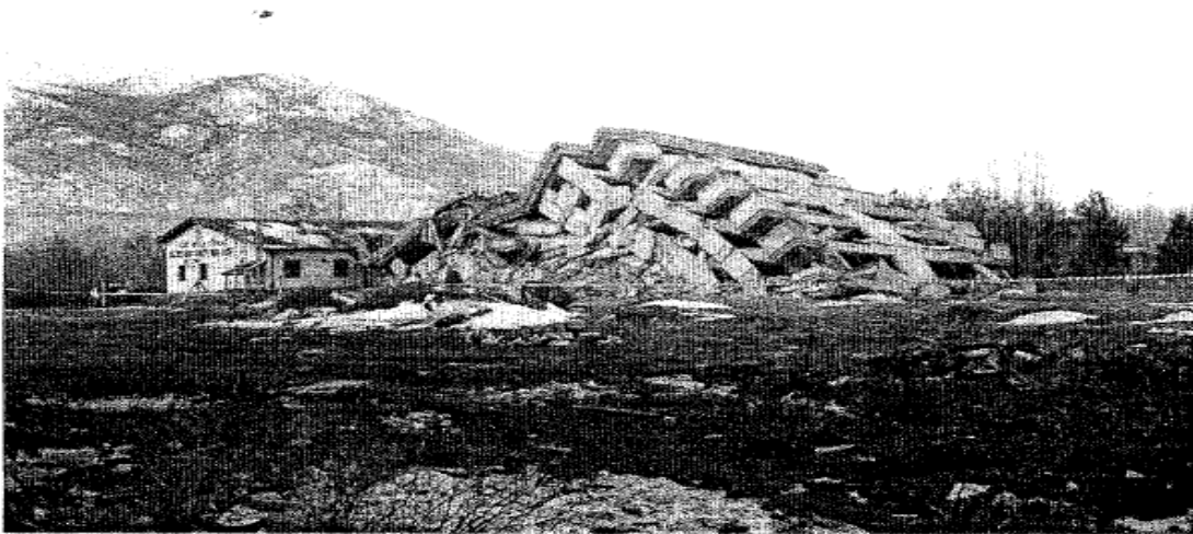
Şekil 6: Konut Yapı Kooperatifi İnşaatından Hasar Görüntüsü – 2
